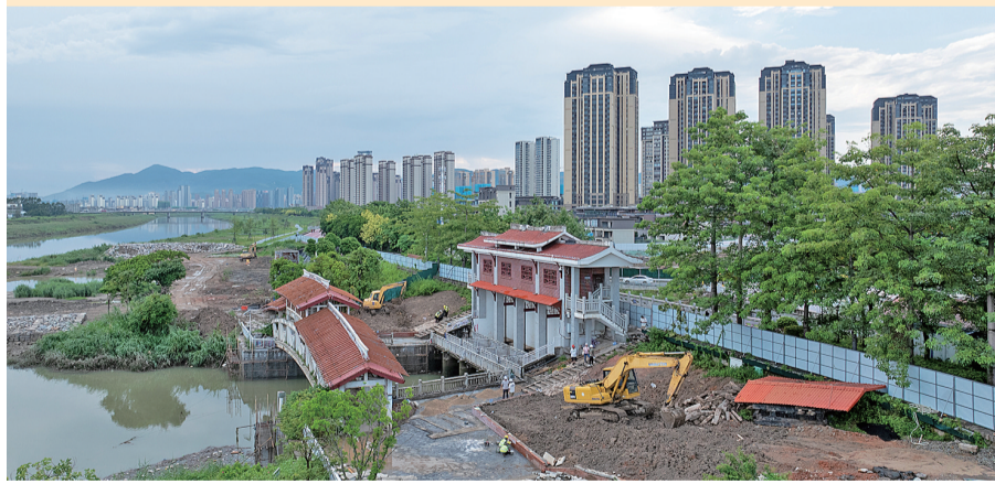
▲港利水闸拆除重建施工现场。 ▲张镇水闸维修加固现场。
