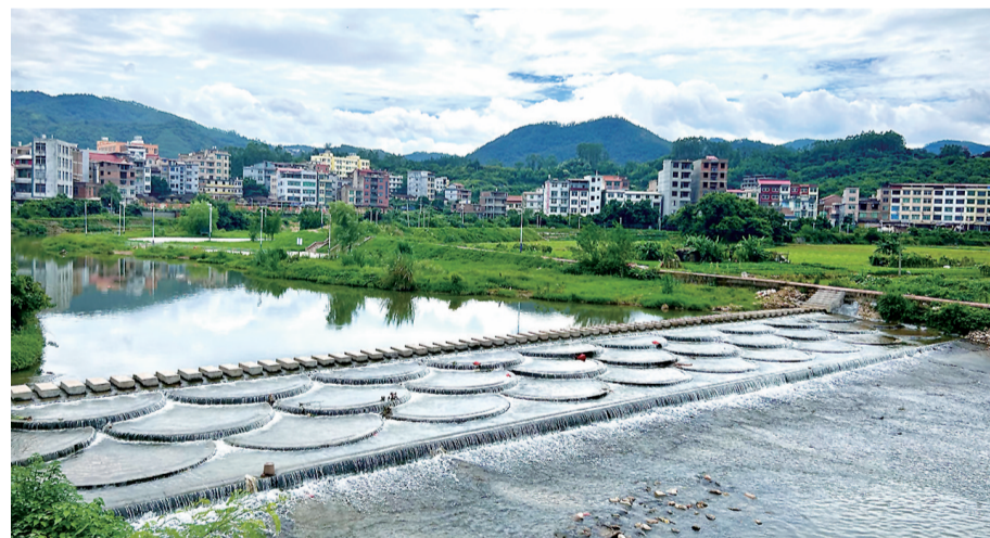
在原有坝顶新建汀步，并将坝体下游面由斜坡式改为鱼鳞式，鱼鳞圆弧半径达2.5米，满足了村民出行与休闲需求。通过改造枫慈溪张厝鱼鳞坝，不仅提高枫慈溪河道防洪排涝能力，改善周边水生态环境，而且提升园庄镇集镇区的整体景观效果，为
