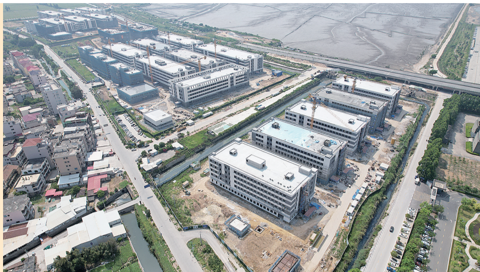
东海鞋服科技产业园全力以赴抢进度、赶工期，确保在12月底前全部完工。
