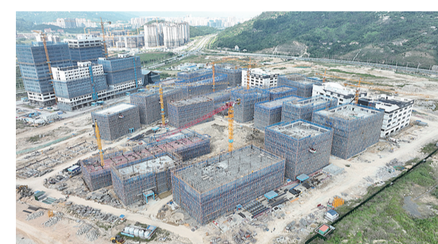
中电科创城核心区项目建设现场。
