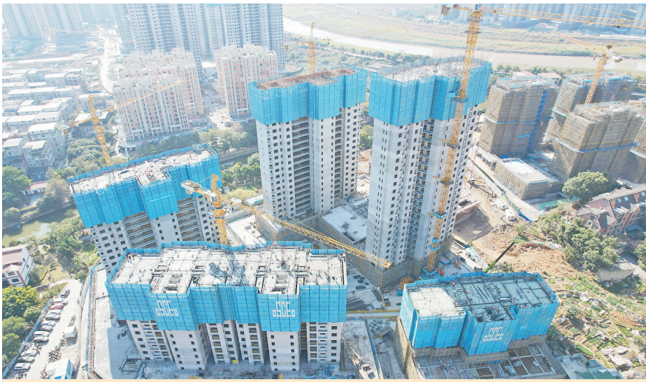
万达广场片区改造项目加快建设进度。
