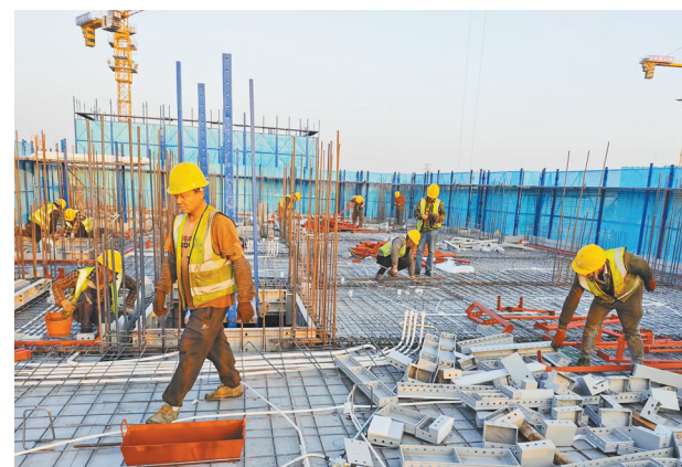
木兰铁岭安置房项目现场，工人们忙施工，赶进度。
