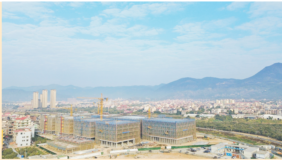
城厢区“专精特新”产业园主体结构实现封顶。
