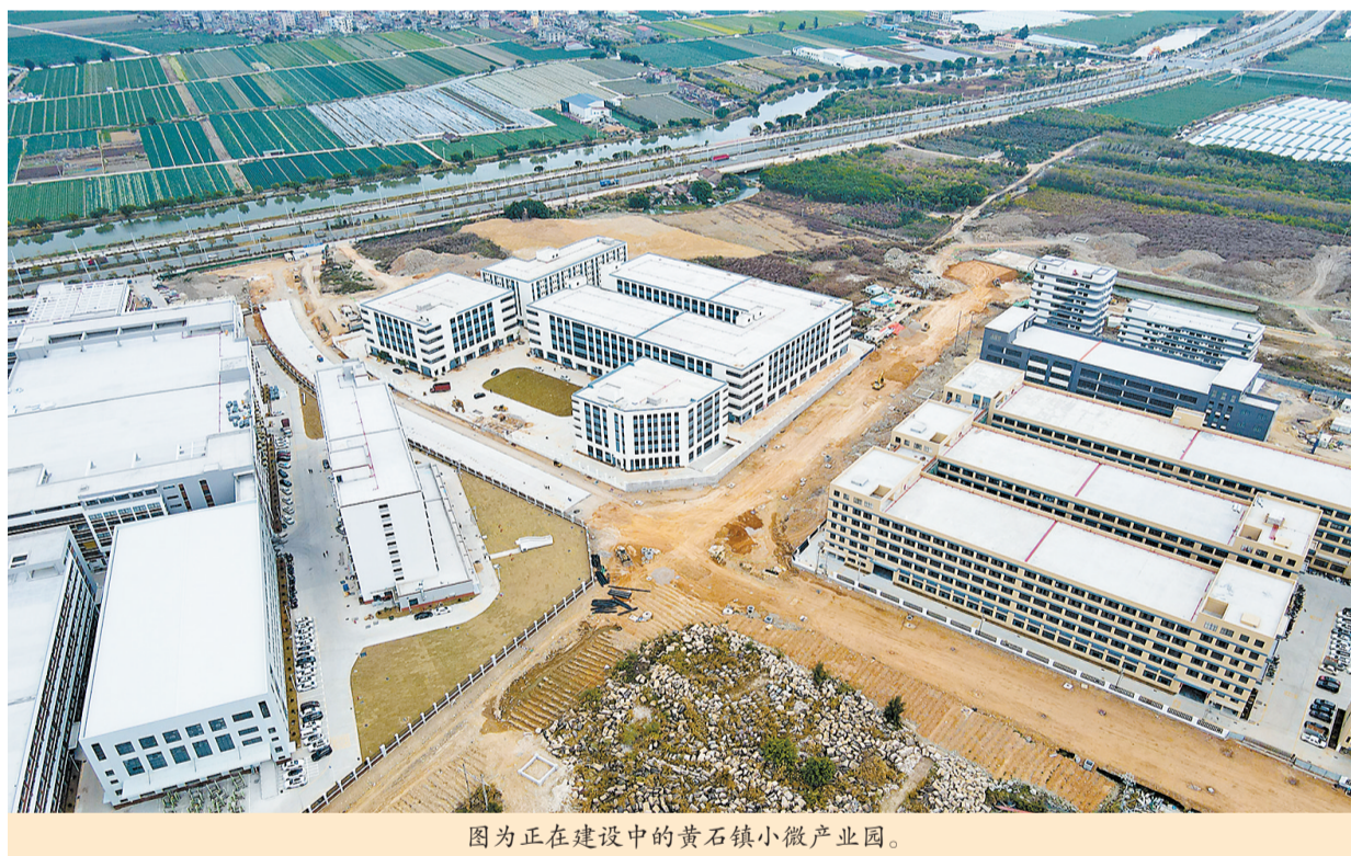
图为正在建设中的黄石镇小微产业园。
