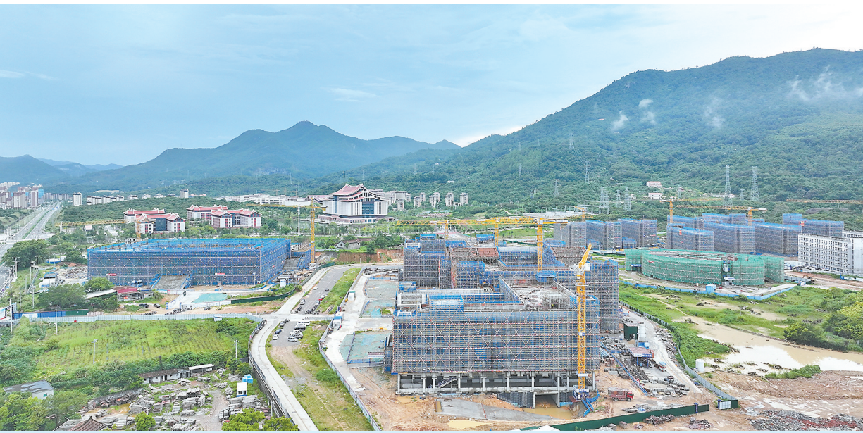
7月14日,莆田学院迁建项目二期(医学组团)项目建设现场工作人员繁忙作业,部分教学楼已进入装修阶段。整体施工按计划有序推进。 全媒体记者 陈斌 摄
