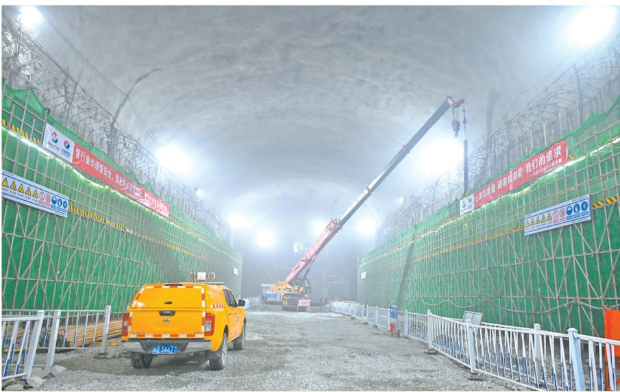
图为木兰抽水蓄能电站地下厂房岩壁梁浇筑顺利完成。全媒体记者 杨怡玲 摄
