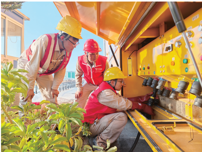
保电人员将应急发电车接入活动现场。
