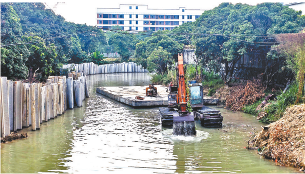
西庄淡公园水系正在进行护坡清淤。
