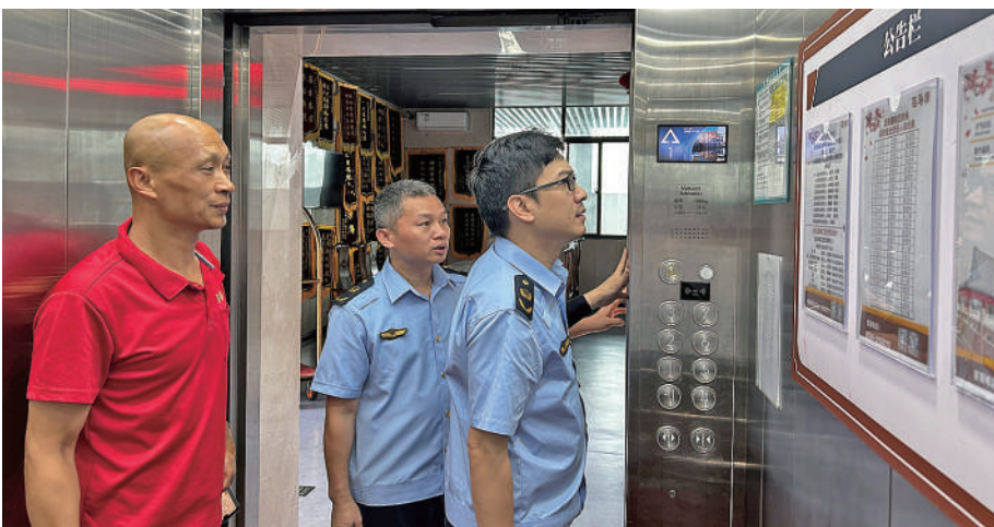
图为秀屿区市场监管局工作人员查看电梯维保记录等情况。
