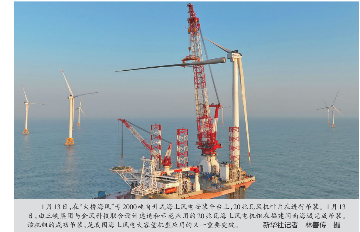
1月13日，在“大桥海风”号2000吨自升式海上风电安装平台上，20兆瓦风机叶片在进行吊装。1月13日，由三峡集团与金风科技联合设计建造和示范应用的20兆瓦海上风电机组在福建闽南海域完成吊装。该机组的成功吊装，是我国海上风电大容量机型应用的又一重要突破。
