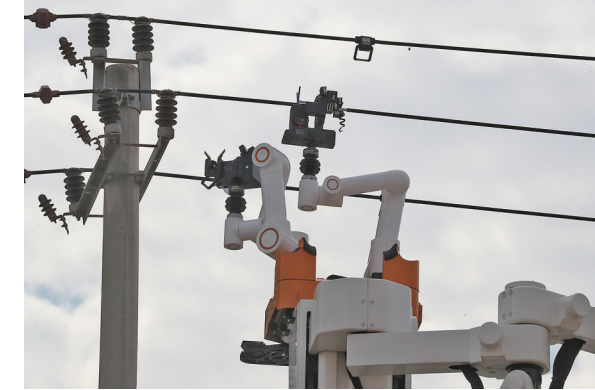
图为带电作业机器人自主开展剥线作业。
