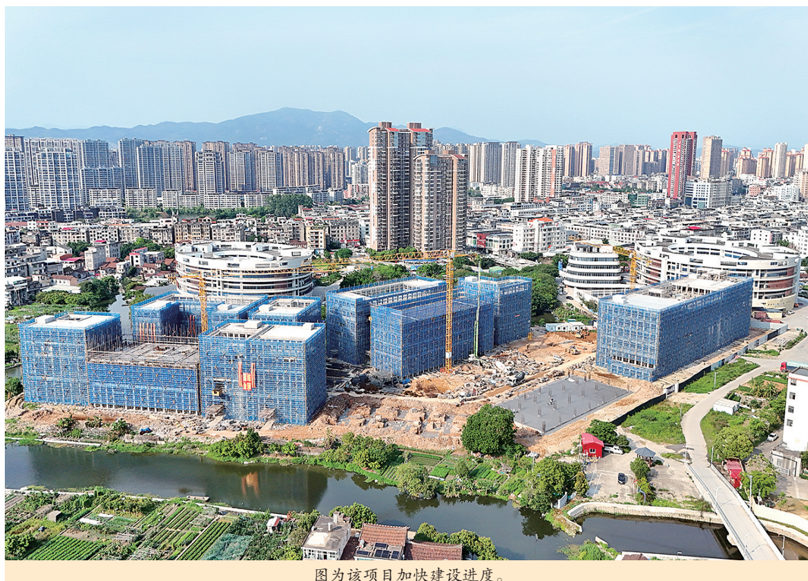
图为该项目加快建设进度。
