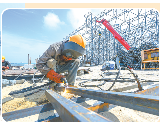
▲项目现场，工人们正在搭建大型智能化养殖平台。 ▲秀屿区智慧科技海洋牧场项目（一期）加快建设。 全媒体记者 蔡昊 摄
